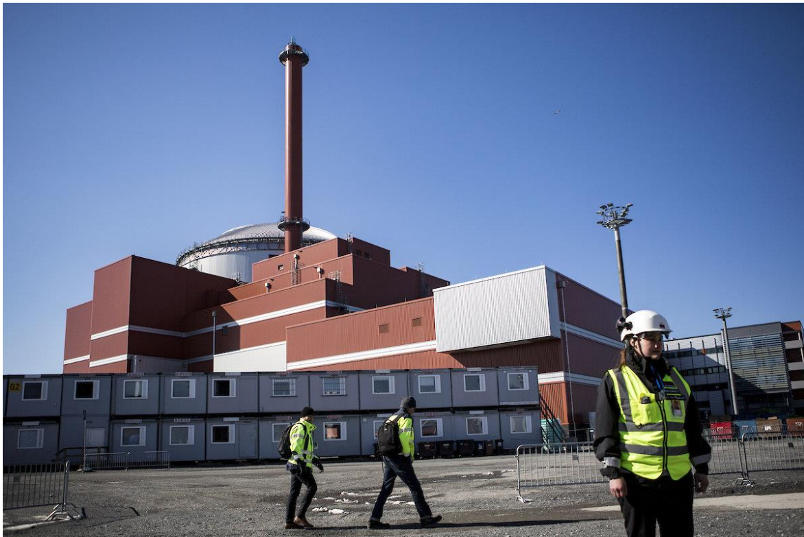
De derde, splinternieuwe reactor van de kerncentrale Olkiluoto. In tegenstelling tot andere landen investeert Finland juist in kernenergie.
