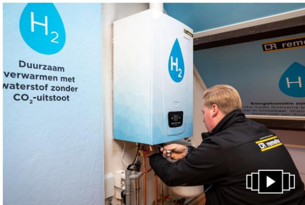
BIJ EEN PROEF IN UITHOORN WERDEN VERWARMINGSKETELS OP WATERSTOF OPGEHANGEN. FOTO REMEHA
